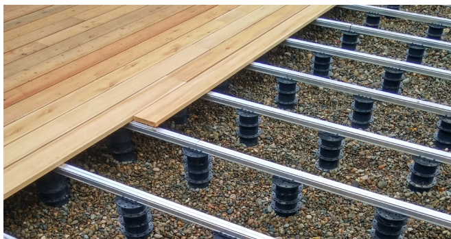
Эксплуатируемая крыша частного дома, Подмосковье
